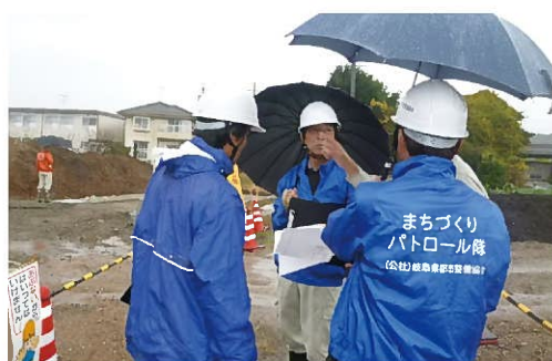
(現場パトロール状況) ー
