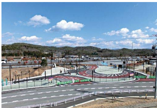
【東海環状自動車道 五斗蒔スマートIC】
