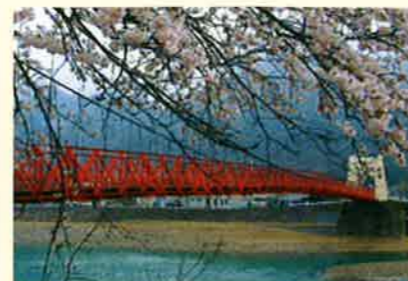
美濃橋（日本最古の近代吊り橋）
