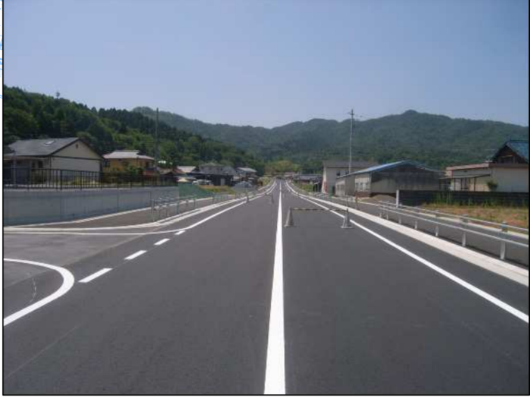
④妻木線区画線施工
