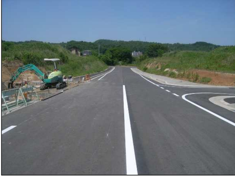
③妻木笠原線区画線施工
