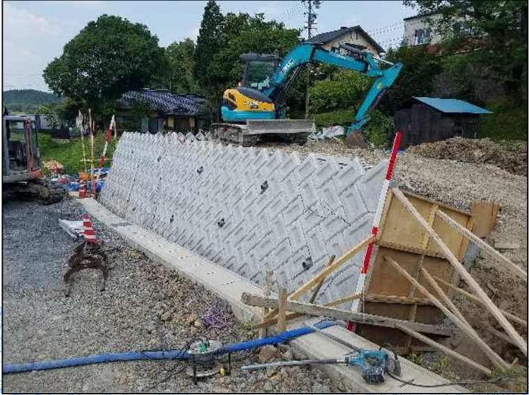
①8街区ブロック積み施工状況
