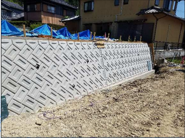
②32街区ブロック積み施工状況
