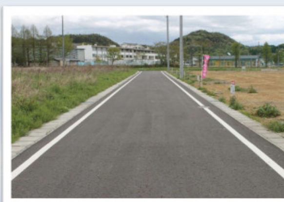
③ 集合保留地北側 道路舗装完了状況
