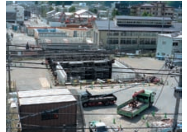
アンダーパス全景
