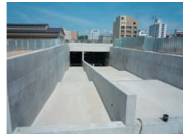
アンダーパス西側取付道路
