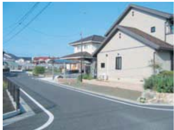
完成した街並み（2）
