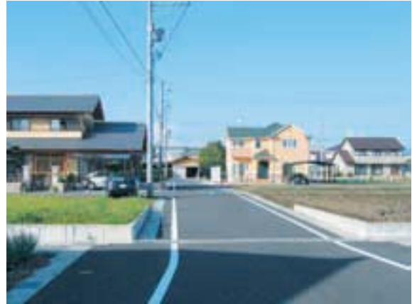
完成した街並み（1）
