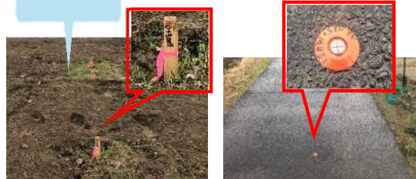
▲新設道路の中心点に鉋や木杭を設置▲
