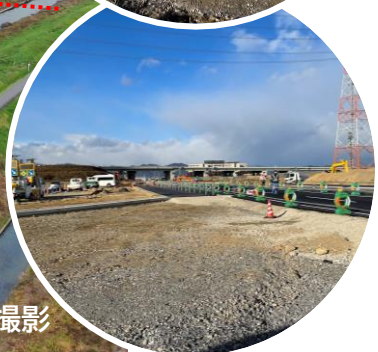
県道岐阜県南大野線 拡幅工事中
