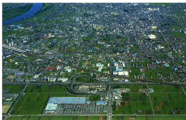
基盤整備が進む岐阜羽島インター、JR岐阜羽島駅周辺
